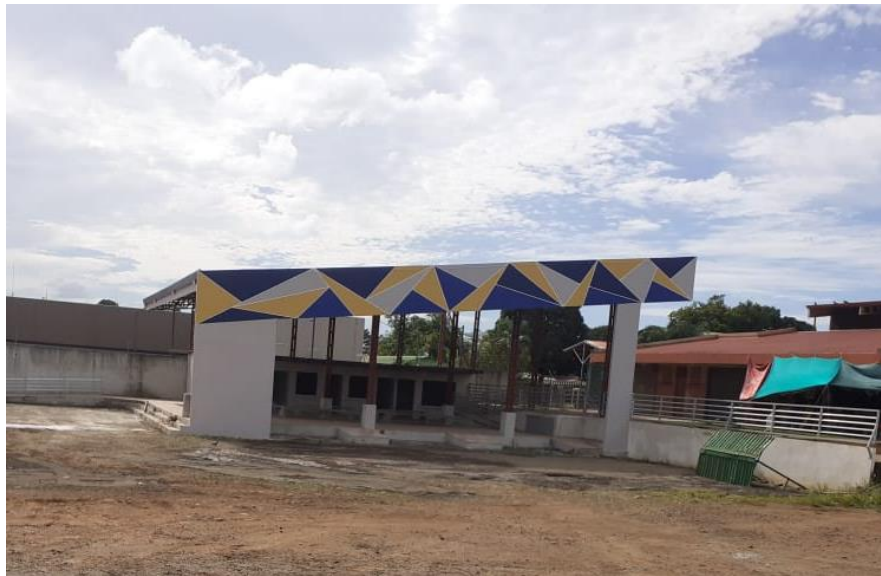
Imagen 2. Reconstrucción de la terminal de buses de Los Chiles.
