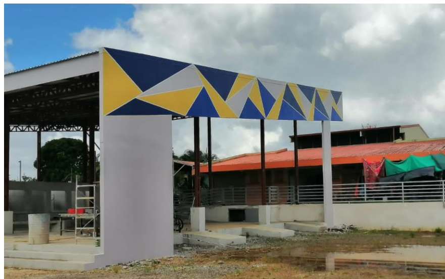
Imagen 3. Reconstrucción de la terminal de buses de Los Chiles.
